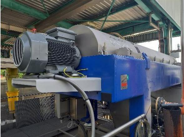
L'intera sezione impiantistica ha un'elevata efficienza di rimozione dei solidi sospesi totali, con un rendimento superiore al 90%, garantita anche dalla complementarità delle due sezioni di filtrazione idrodinamica e di centrifugazione.
