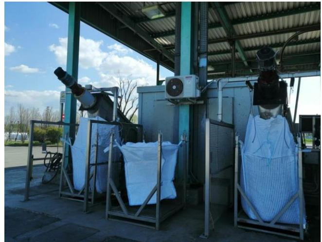
I sacchi contenenti le sostanze solide estratte, una volta riempiti, vengono depositati nel piazzale esterno di disidratazione e stoccaggio, dotato di un sistema di raccolta delle acque meteoriche e di percolazione collegato, tramite pompaggio, alla linea di separazione solido – liquido.
