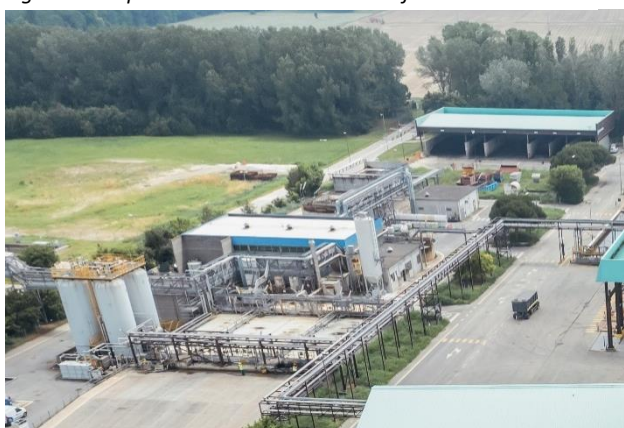
Figura 16 Impianto trattamento chimico-fisico
