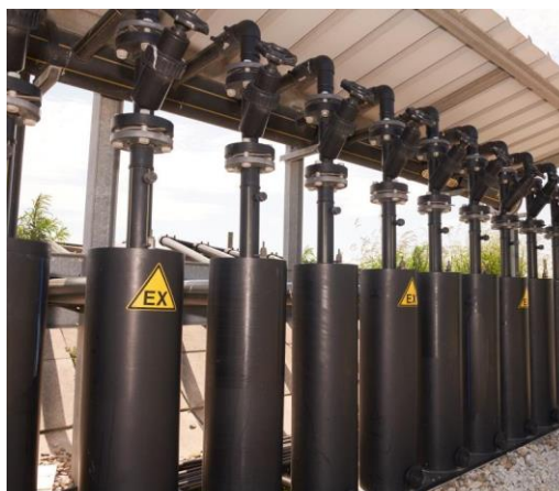
Figura 14 Sottostazioni di regolazione
