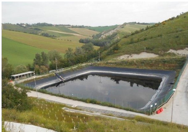
Figura 20 Vasche di stoccaggio percolato (V4 e V3)
