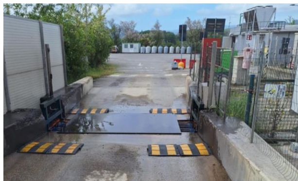
Figura 16 Impianto di lavaggio ruote
