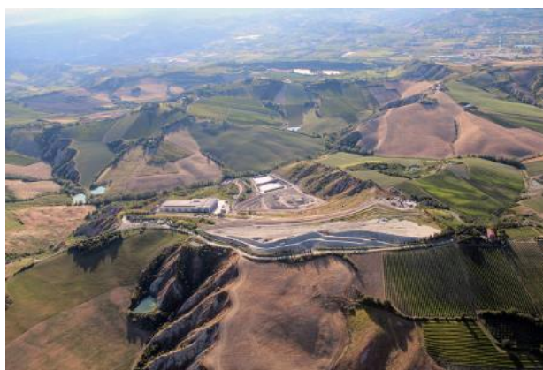
Figura 42 Foto del sito
