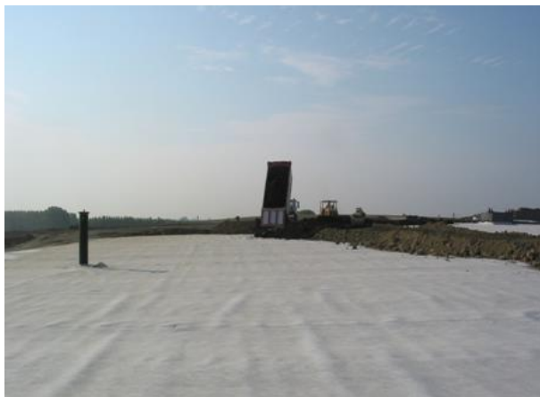
Figura 7 Operazioni di copertura definitiva
