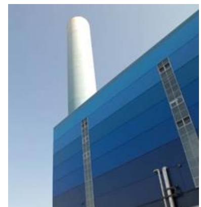
Figura 11 Particolare del camino
