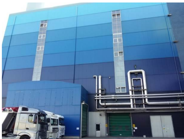
Figura 42 Particolare dell'area di scarico polverini
