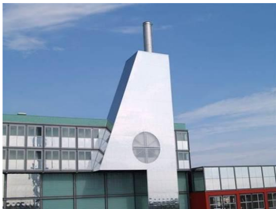
Figura 11 Particolare del camino dell'impianto
