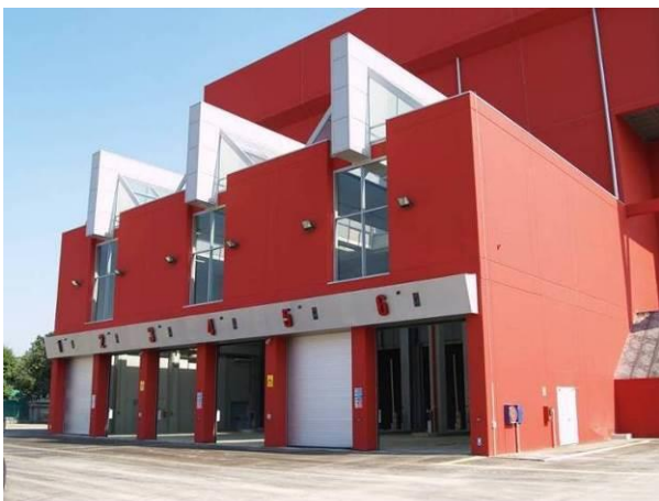
Figura 7 Particolare dell'avanfossa del termovalorizzatore
