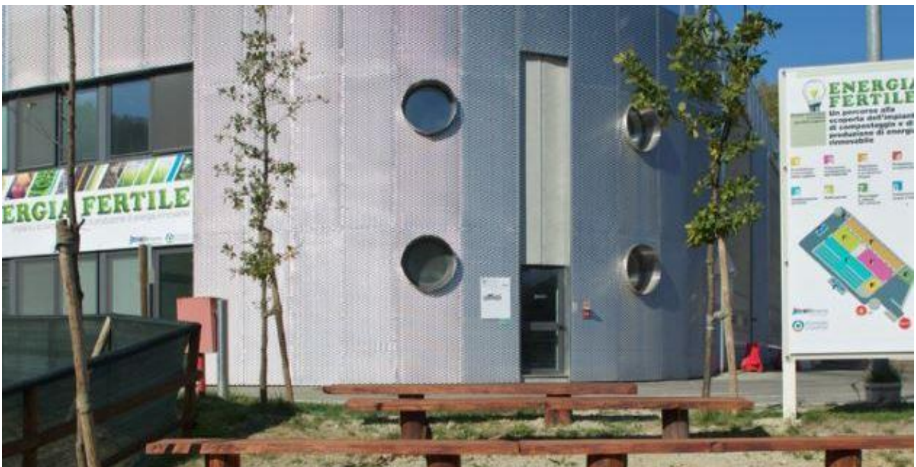
Figura 1 Particolare dell'impianto di compostaggio
