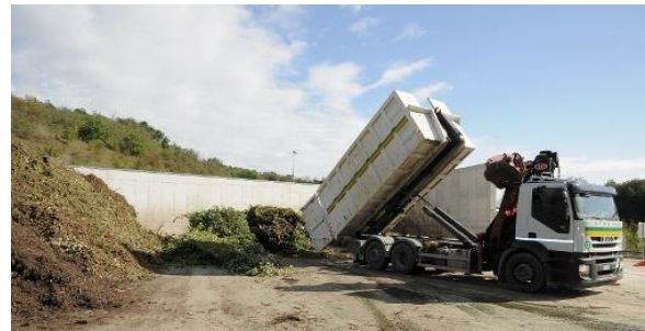
Figura 12 Conferimento rifiuto ligneo-cellulosico
