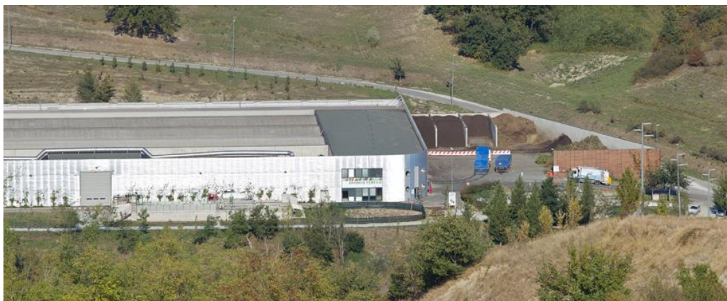
Figura 7 Vista dell'impianto di compostaggio
