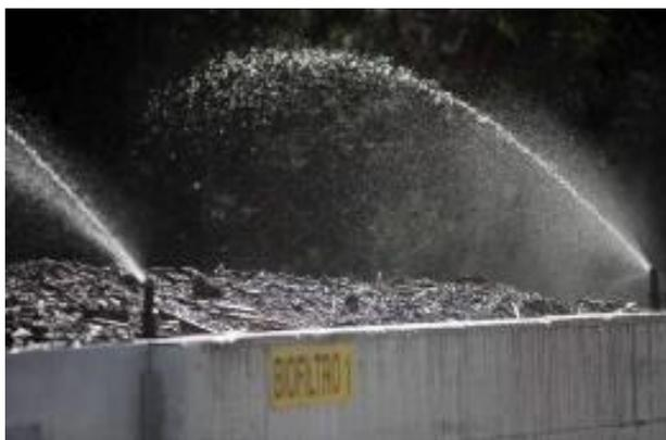
Si tratta di un impianto di abbattimento dell'aria basato sul principio della degradazione biologica dei composti contenuti nell'effluente da trattare. Le sostanze odorigene sono fermate da un letto filtrante costituito da legno triturato e ossidate ad anidride carbonica ed acqua dall'attività dei microorganismi qui insediatisi.
