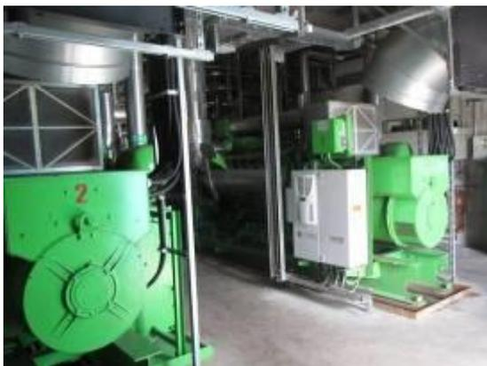
Figura 11 Sistema recupero calore dai fumi
