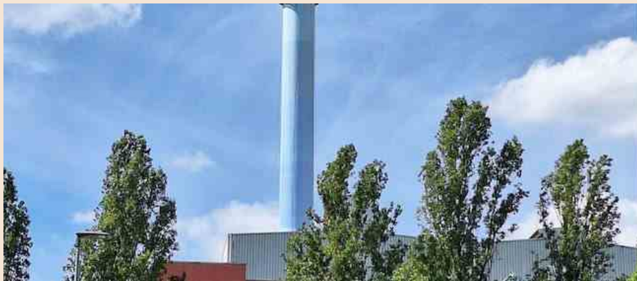
▲ Termovalorizzatore di Herambiente a Ferrara
