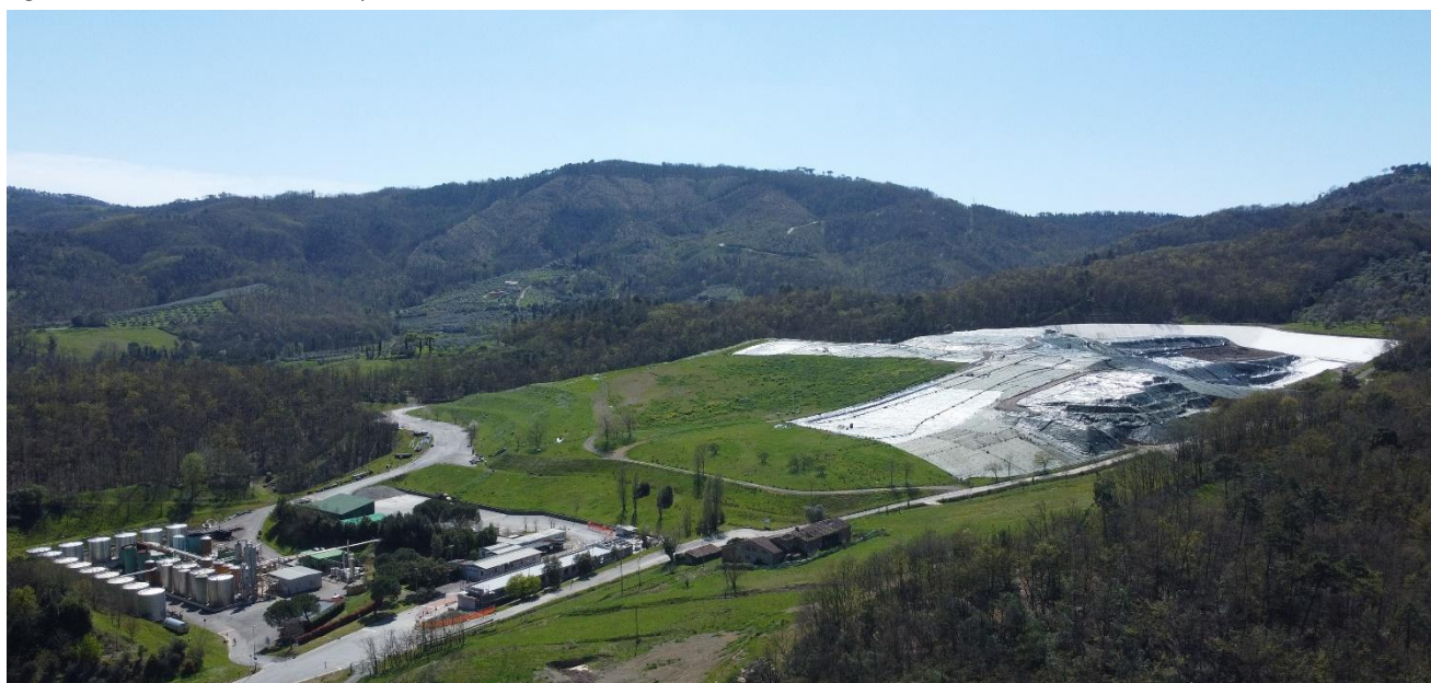
Figura 5 Vista dall'alto del sito impiantistico
