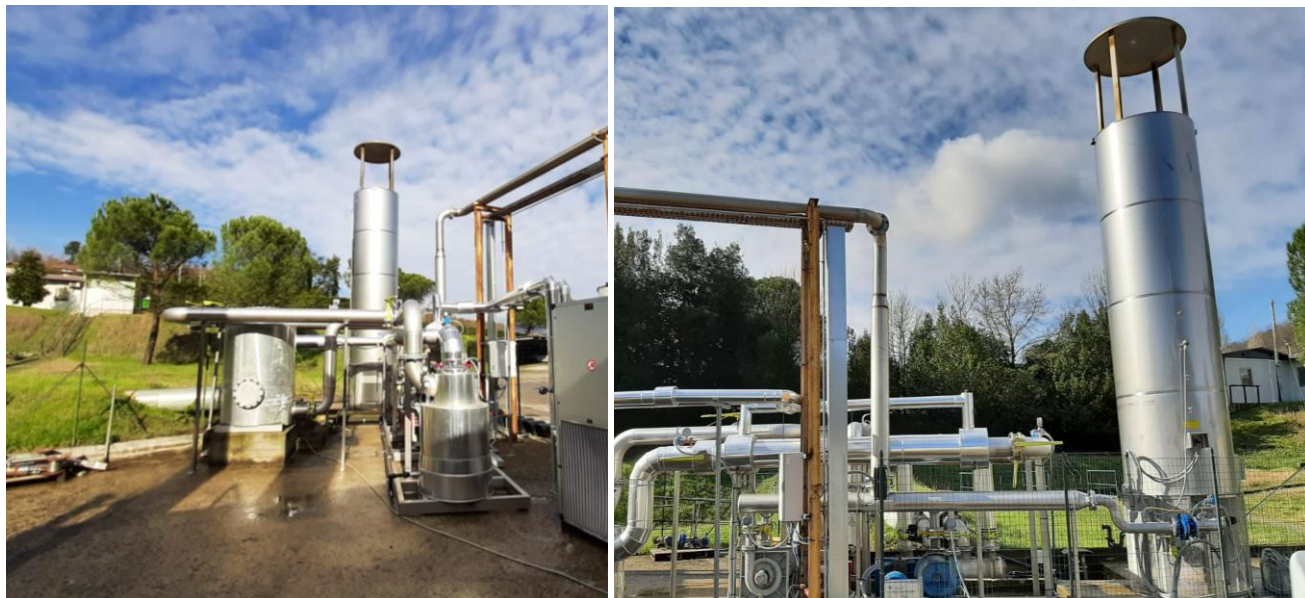
Figura 10 Particolari della nuova torcia
