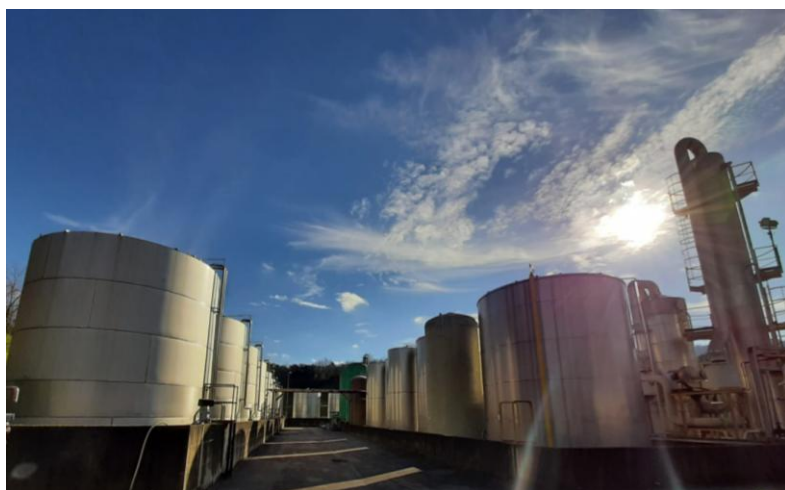
Figura 9 Serbatoi di stoccaggio del percolato
