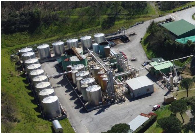
Figura 12 Vista dell'impianto di trattamento
