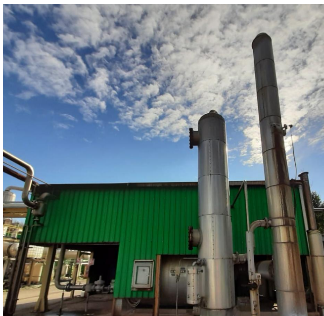
Figura 20 Particolare del punto di emissione della caldaia
