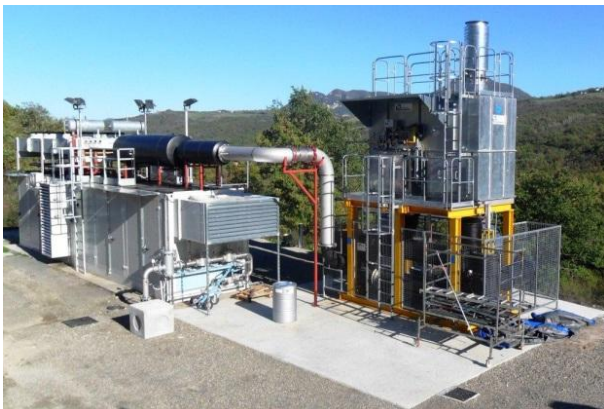
Figura 7 Motogeneratore per la produzione di energia elettrica da biogas
