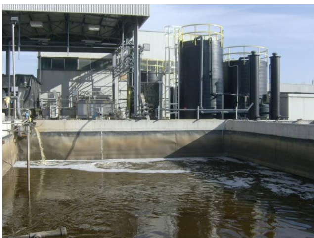
Figura 18 Vasca di interposizione finale
