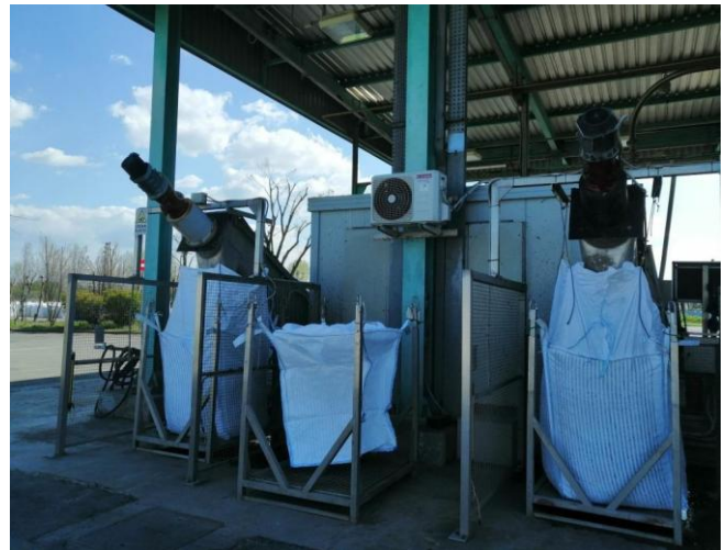
Figura 11 Big bags di raccolta delle sostanze solide provenienti dal processo di dissabbiatura
