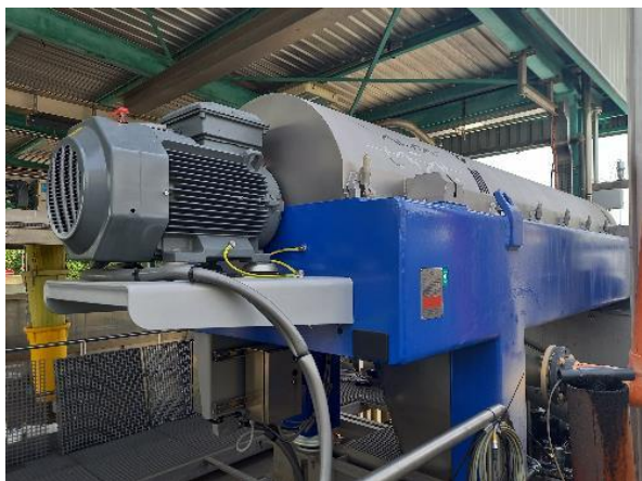
Figura 12 Nuova sezione di centrifugazione
