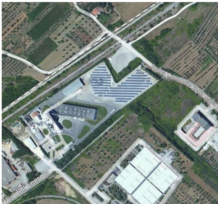
Figura 2 Vista area del sito impiantistico
