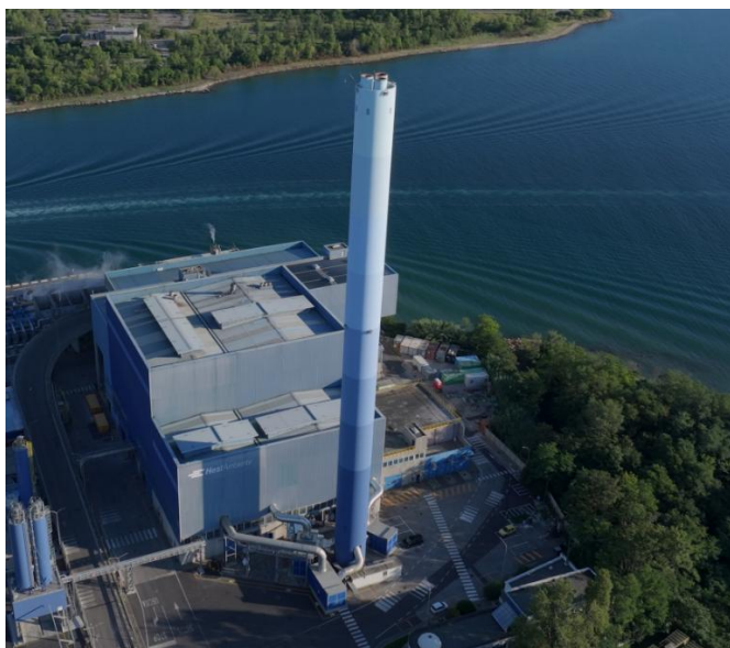
Figura 13 Camino del termovalorizzatore di Trieste
