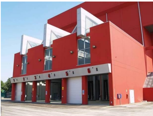
Figura 6 Particolare dell'avanfossa del termovalorizzatore
