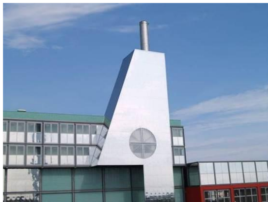
Figura 10 Particolare del camino dell'impianto
