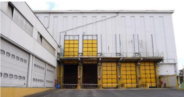
Figura 13 Visione frontale della fossa ausiliaria
