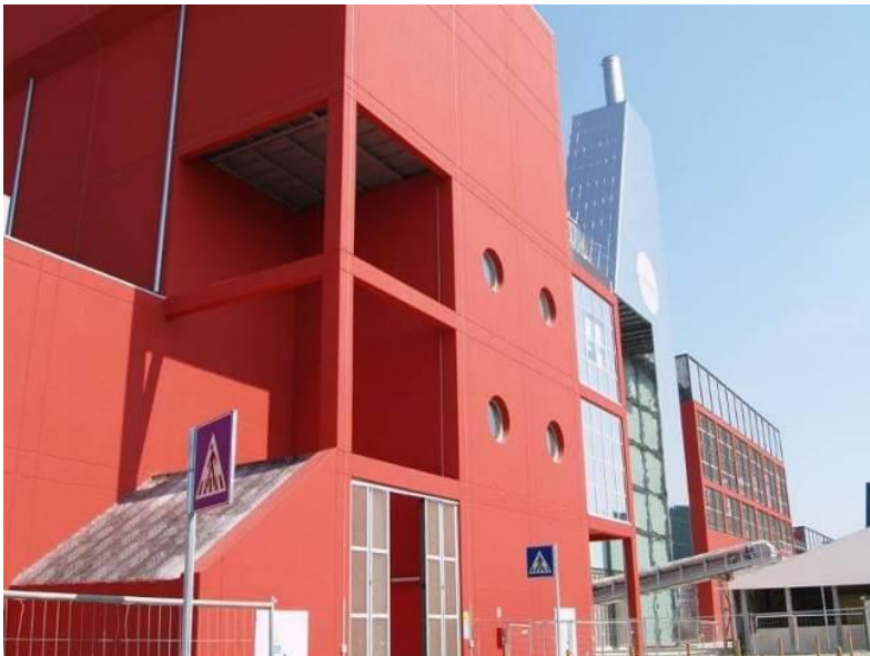
Figura 44 Facciata est con nastro di trasporto scorie
