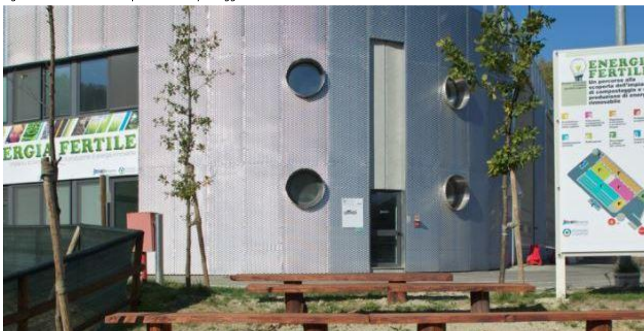
Figura 1 Particolare dell'impianto di compostaggio
