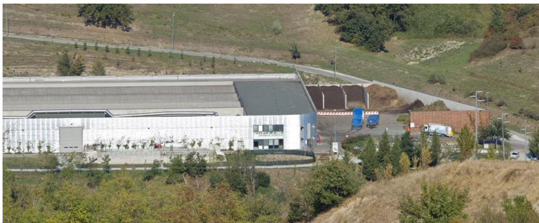
Figura 7 Vista dell'impianto di compostaggio
