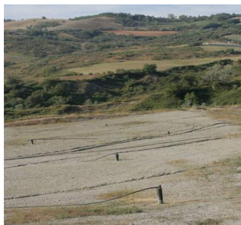
Figura 24 Sistema di estrazione del biogas
