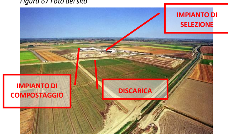
Figura 67 Foto del sito
