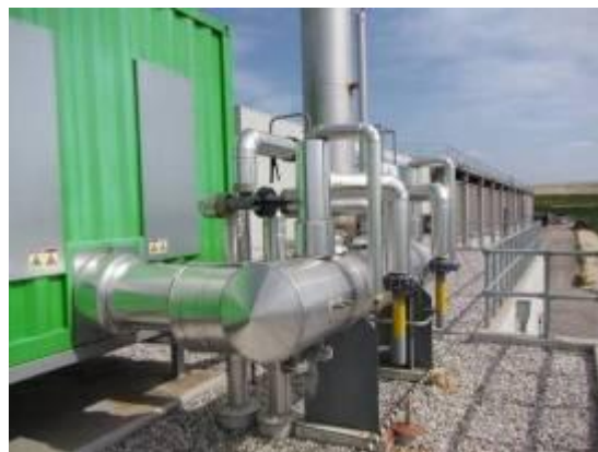
Figura 11 Sistema recupero calore dai fumi
