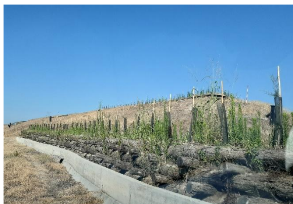
Figura 32 Particolare delle "pareti krainer"
