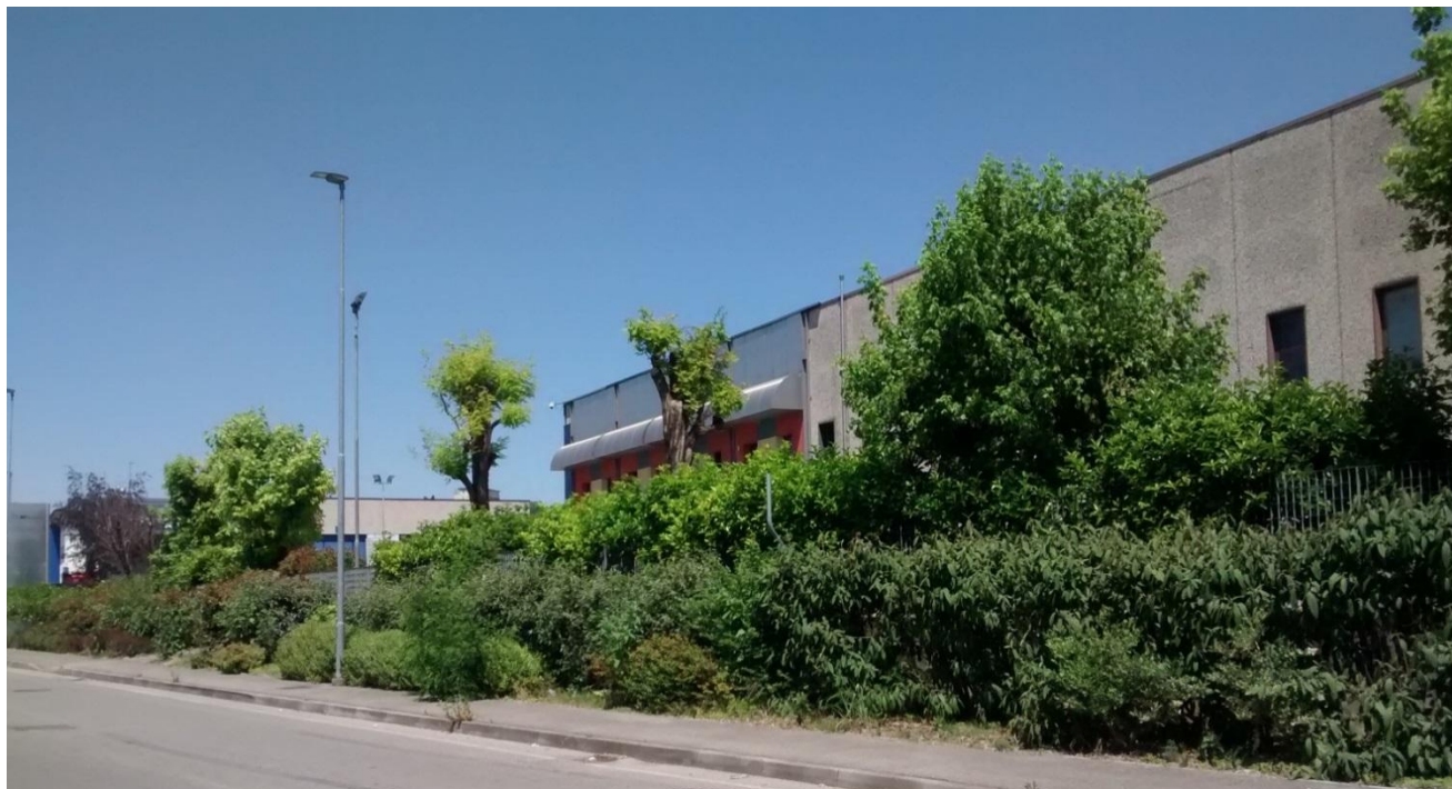
Figura 1 Vista esterna dell'Impianto
